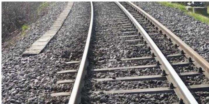
Da un punto di vista tecnico e finanziario l'integrazione comporta un impegno limitato in quanto si tratta di inserire un binario supplementare fra i due binari dello scartamento normale. Si possono fare transitare dei mezzi leggeri (tram) anche sulle linee esistenti e si riesce a creare un avanzato sistema di mezzi pubblici urbani e per le valli sfruttando le infrastrutture già esistenti.
